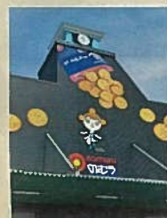
現在の工場外観
